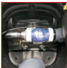
Rückschlagventil RSK und Entleerungspumpe
